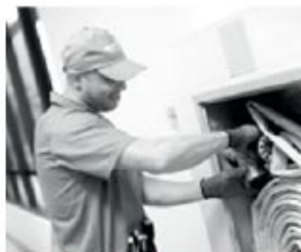
COMBATE A INCÊNDIO
